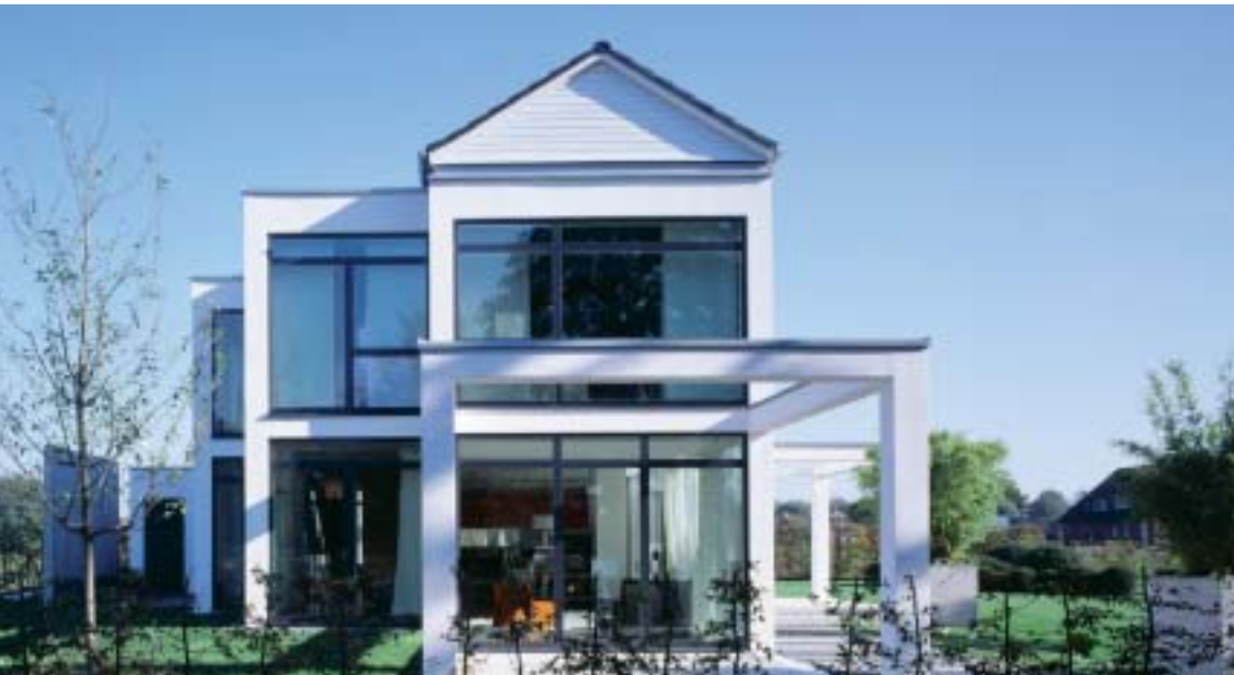
Das im Baukastenprinzip konzipierte Gebäude lässt sich durch seinen modularen Aufbau einfach weiterentwickeln.
