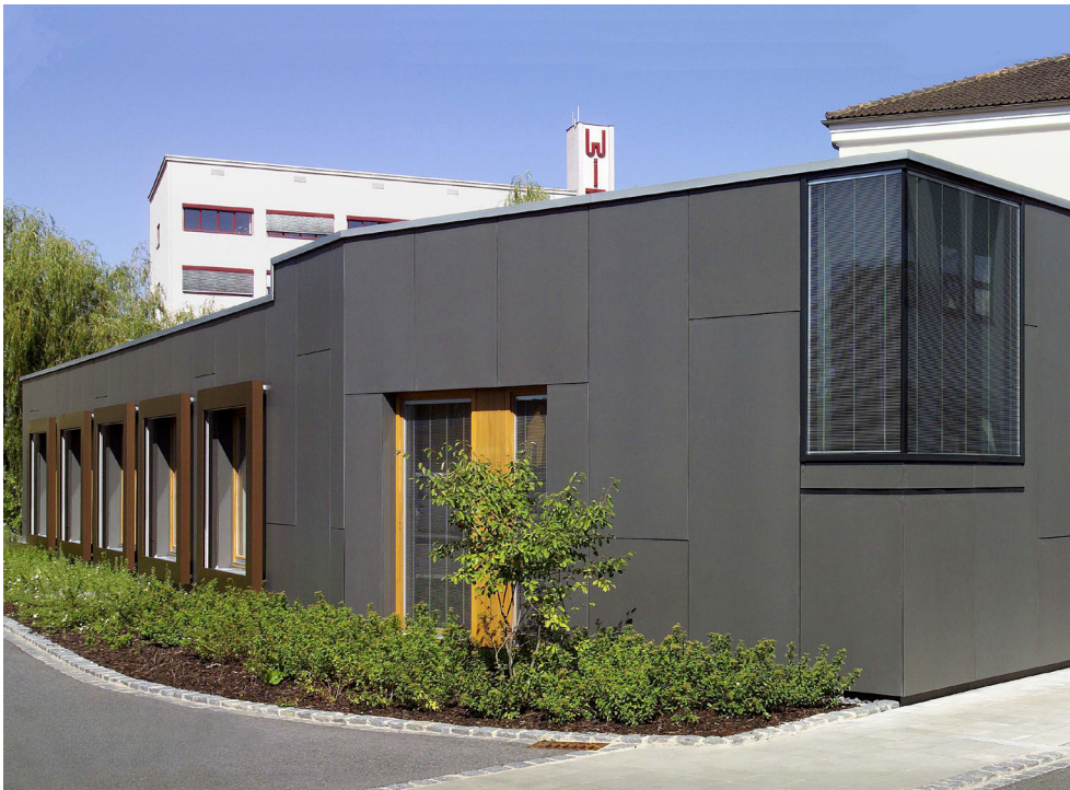
Durchgefärbte Fassadentafeln von Eternit und Lärchenholzfenster mit markanten Kupferrahmen unterstreichen in Weiden das elegante Erscheinungsbild des eingeschossigen Service-Centers. Fotos: Sommer & Spahn GmbH, Amberg
