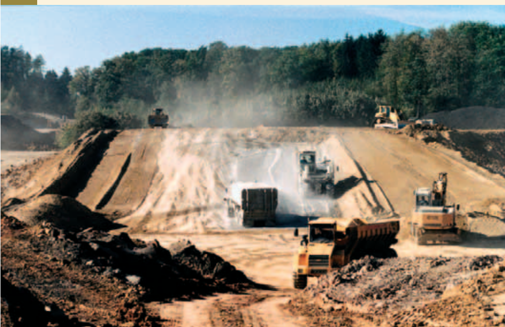
Abb. 2: Die Stabilisierung mit Zement erfolgt im gesamten Erdbau: bei Dämmen, als Hinterfüllung und bei Einschnitten.
