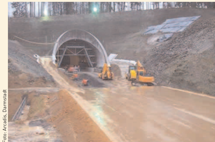
Abb. 4: Vorteilhaft für Verkehrs- und Erdbauwerke: Die Bodenstabilisierung mit Zement erhöht die Eigensteifigkeit und reduziert den Erddruck.
